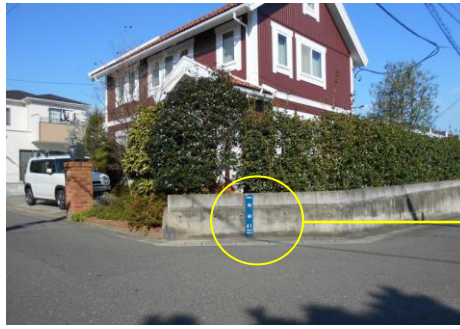
取付状況 コンクリートの腰壁に
