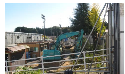
敷地西側の倉庫撤去
