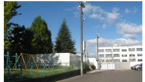
仮設校舎と工事範囲の仮囲い
