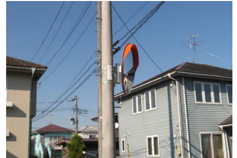
通信線の電柱に取り付けできた
