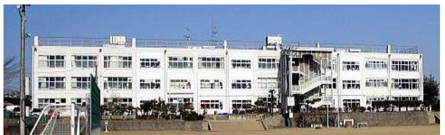
解体前の旧校舎南面（中山小HPより）
