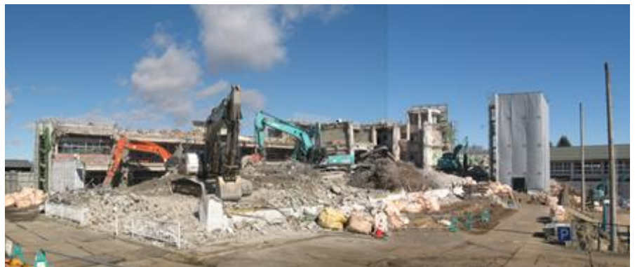
旧校舎解体状況全景 2月17日
