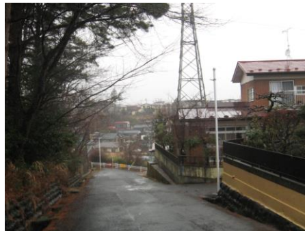
新設された街灯
