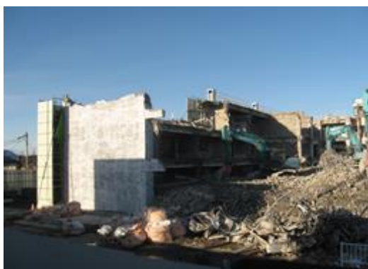
旧校舎解体状況 西面より
