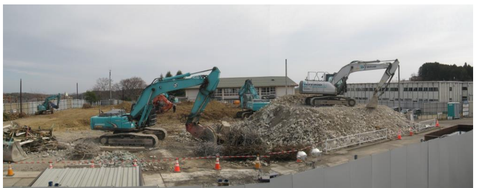
旧校舎解体状況全景 西側より 3月17日
